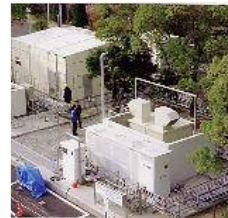
水素供給 ステーション
